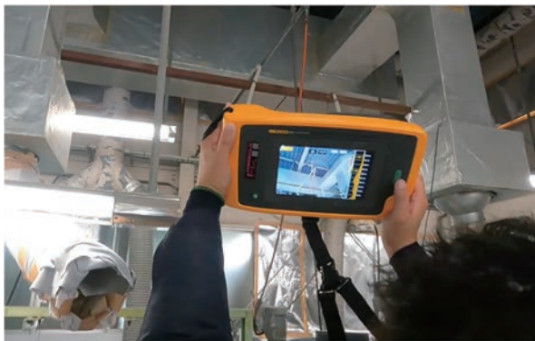
図3 エア漏れ検査サービス
